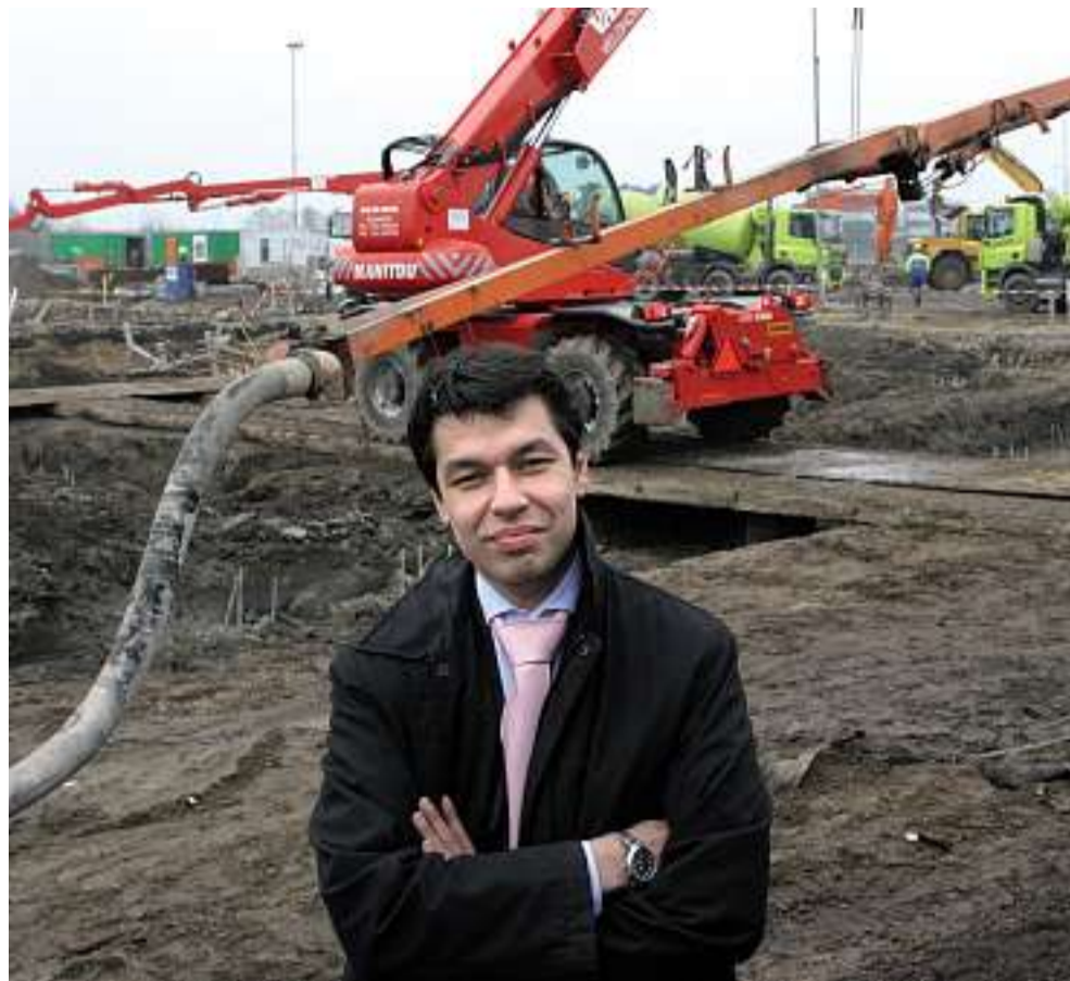
PRC-adviseur Egon Jenniskens op de bouwplaats van het nieuwe datacenter
