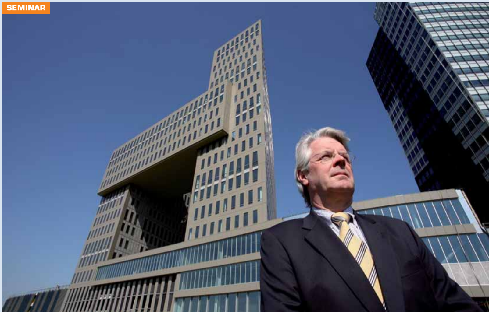
Alphonse Hanlo bij kantoorgebouw Spolderwerk II; Electrabel in Zwolle
