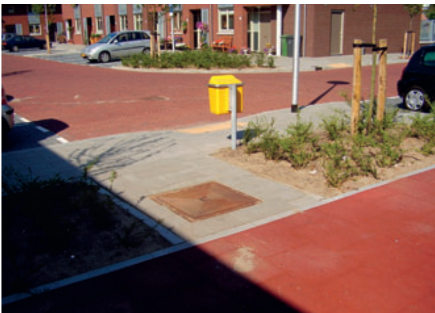
Wko-bronnen kunnen onopvallend worden weggewerkt in de openbare ruimte. In sommige gevallen geeft dit echter aanleiding tot extra exploitatiekosten.
