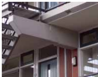
Isoleren van dichte geveldelen
