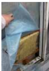
Goede dampdichte lagen aan de binnenzijde en waterkerende maar dampopen lagen aan de buitenzijde voorkomen vochtschade en afname van de thermische isolatiewaarde
